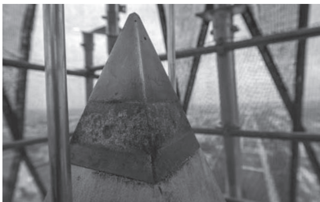
▲ شکل ۳- کلاهک آلومینیومی در بالاتری نقطه از نماد یادبود واشنگتن.
